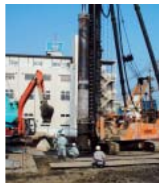
「DYNAWING™」の施工現場
