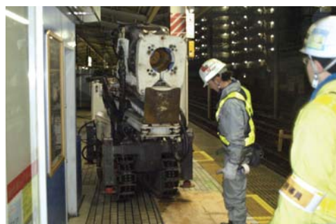
ホームドア設置工事の様子
