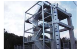
津波避難タワー (宮崎県延岡市)
