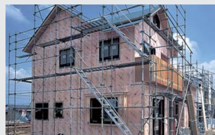
木造住宅の外張り断熱工法を用いた施工現場
