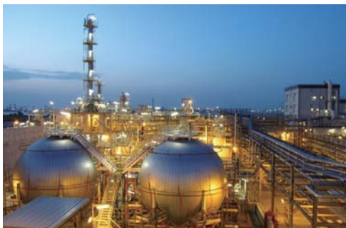
S-SBRシンガポール工場
