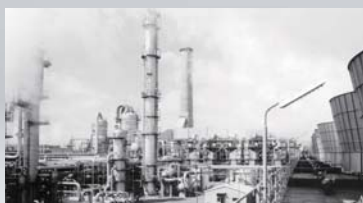
エチレンプラント(岡山県倉敷市)
