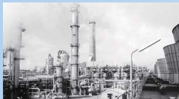
エチレンプラント(岡山県倉敷市)
