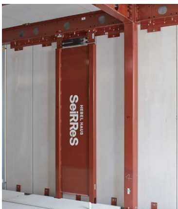
オイルダンパー制震装置「サイレス(SeiRReS)™」
