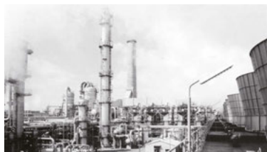
エチレンプラント(岡山県倉敷市)
