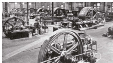
1923年に完成したアンモニア製造設備(宮崎県延岡市)
