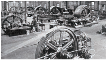
1923年に完成したアンモニア製造設備（宮崎県延岡市）
