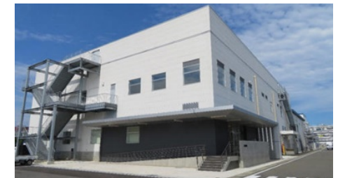
プラノバ紡糸工場（19年9月竣工）
