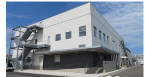
プラノバ紡糸工場 (19年9月竣工)
