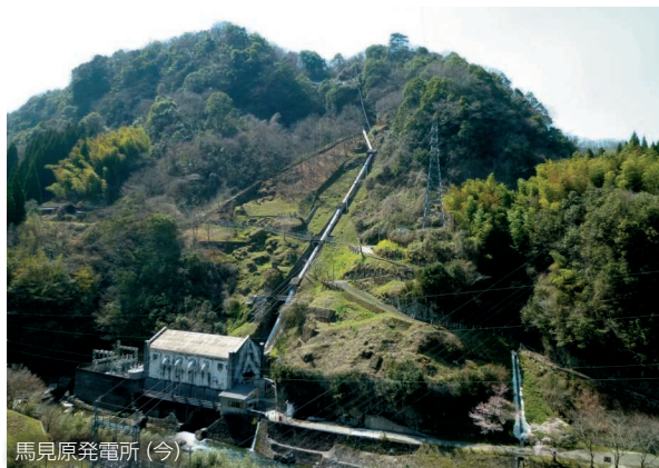
五ヶ瀬川発電所（今）
