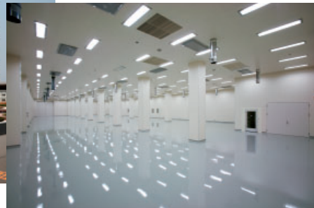
大型クリーンルーム
