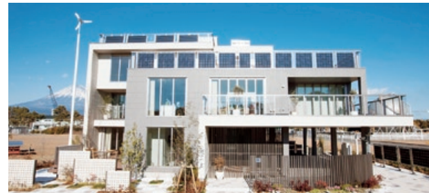
「HH2015」実証棟 2011年12月完成
