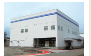
「プラノバ™ BioEX」紡糸工場 外観
