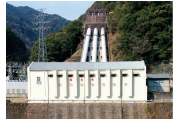
当社が保有する五ヶ瀬川発電所(宮崎県西臼杵郡)(工事前)
